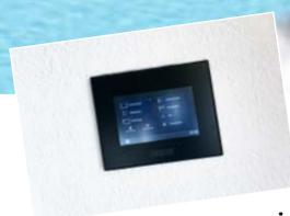
In das Rechteckbecken wurde eine halbrunde, bequeme Treppenanlage über Eck eingebaut, deren zweite Stufe in einer Sitzbank mündet. Am Display der Poolsteuerung „Ospa-BlueControl“ kann der Bauherr die Wasserwerte kontrollieren und bei Bedarf korrigieren. Auch die Wasserattraktionen sind hier aufgeschaltet.
